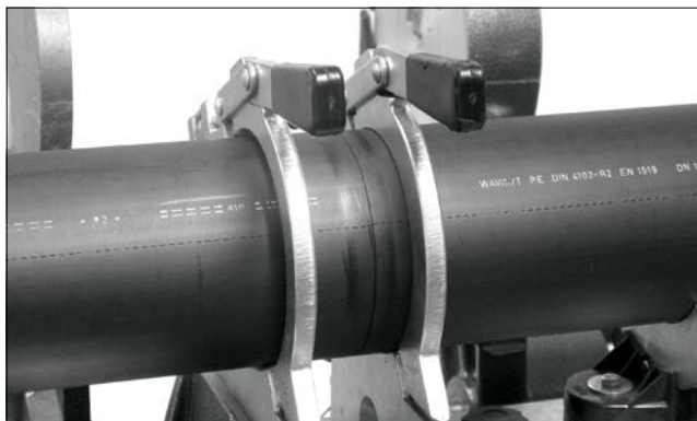
Správně připravené potrubí ke svařování
