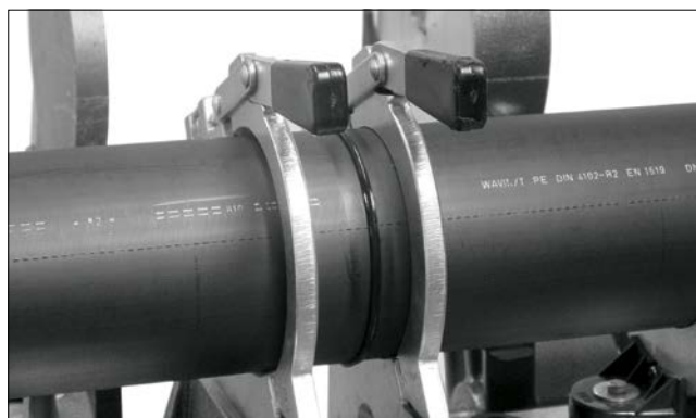
Chladnutí svařeného spoje
