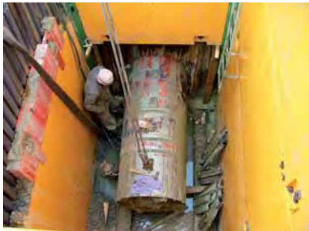
Razicí štít ISEKI DN 800 po protlačení do cílové jámy
