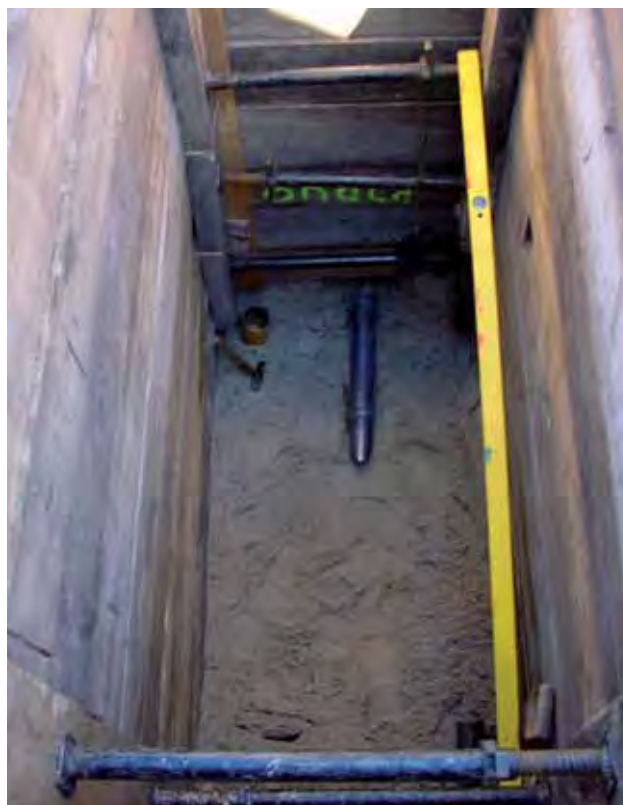
Průchod piloty do cílové šachty napojovaného objektu.
