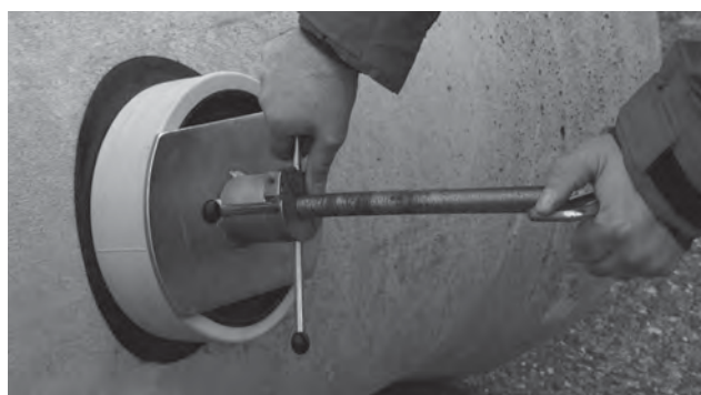
3. Upevnění keramického elementu C pomocí montážní tyče na hlavní kanalizační řad
