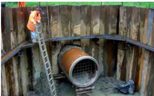
DN 1400 – Karviná, protlačené kameninové potrubí v cílové šachtě
