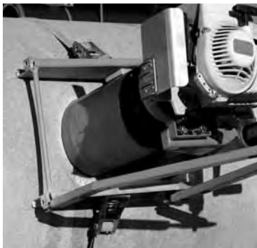
1. Vyvtávka a očištění otvoru průměru 200 – 201 mm
