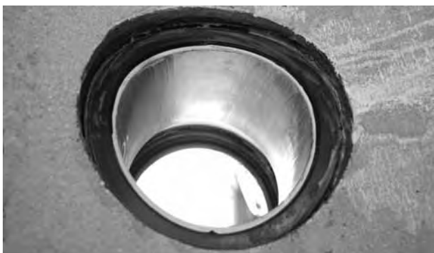
4. Optická kontrola vně i uvnitř trouby (zamezení přesahu napojení do hlavního řadu)
