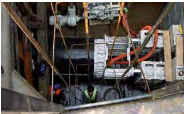
DN 1400 – Karviná, razicí štít ISEKI ve startovací šachtě
