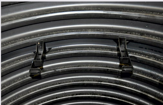
Předpříprava obruče žebříku v šachtové trubce
